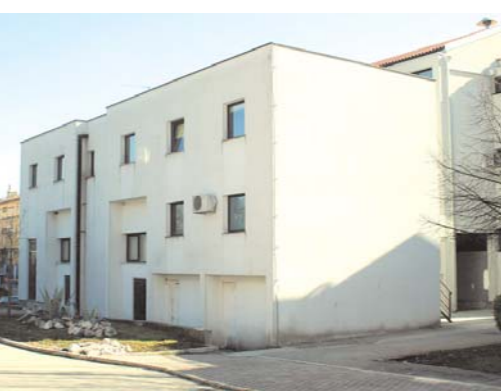
Nakon što je izgrađena pošta, bilo je obećanja o gradnji kino dvorane ali manjeg obujma, no do danas nije izgrađena
